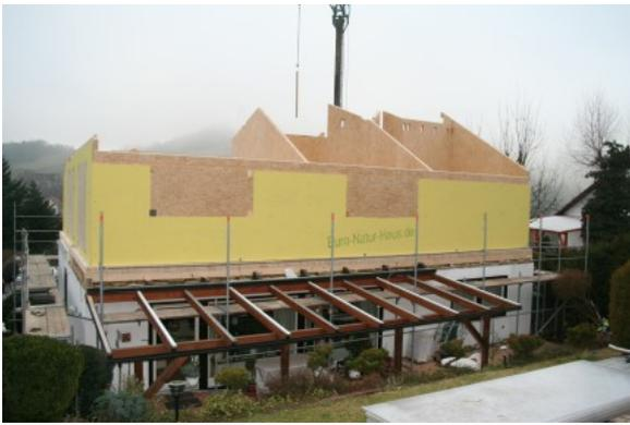
Gerade bei Aufstockungen, wo man in kürzester Zeit die Baumassnahme durchführen muss, ist das Magnum Board System nahezu unschlagbar mit allen Vorteilen des Massivbaues und die Schnelligkeit eines Fertighauses
