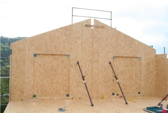
Aufbau der Magnum-Board –Elemente im DG
