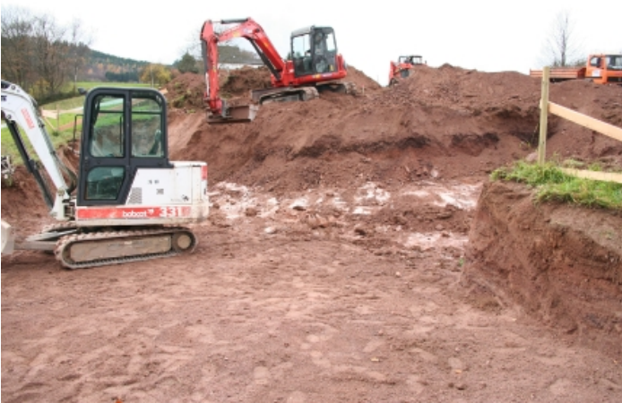
Der Aushub für ein Einfamilienhaus
