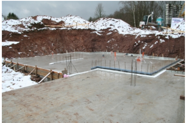
Die Bodenplatte ist fertiggestellt
