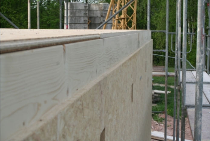
Die Zwischendecke mit Holzbalken erstellt
