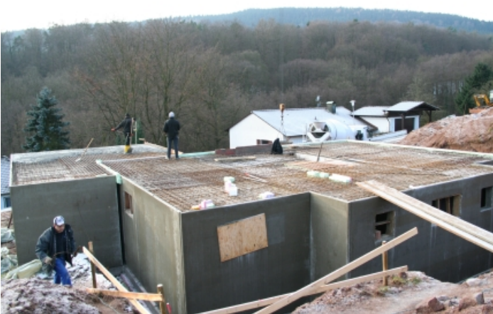
Der Keller im Hangbereich + Garage aus Betonfertigteilen Im Eingangsbereich aus Porotonsteinen Für die Magnum-Board- Montage vorbereitet
