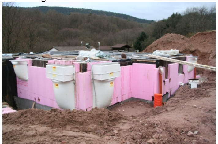
Montage der Lichtschächte
