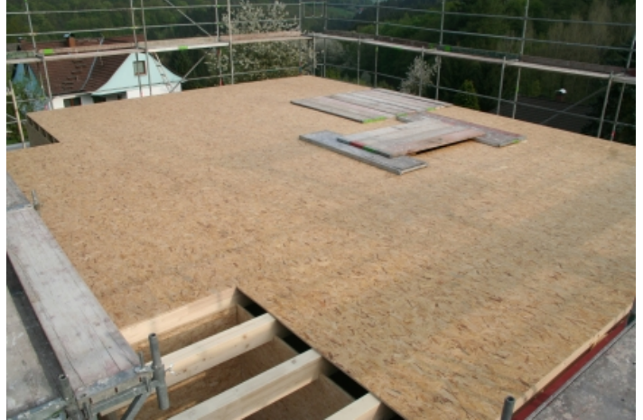
Holzbalkendecke mit Belag
